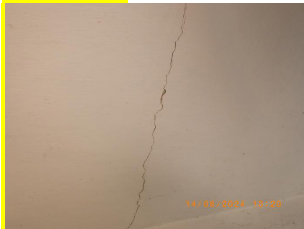
foto 41 1.10 dílna trhliny strop
