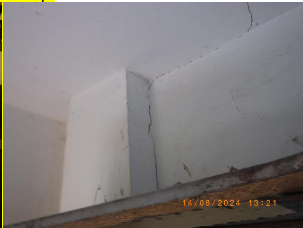
foto 40 1.10 dílna trhliny strop,zdivo
