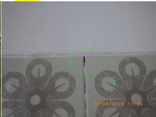
foto 63 2.05 koupelna nevylněná spára obkladu
