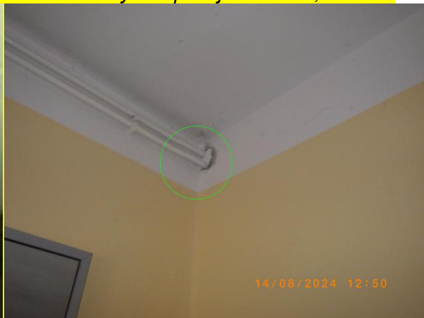
foto 12 1.06 obývací nezapravený průstup
