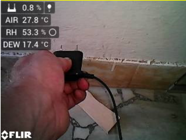
foto 17 1.07 chodba vlhkost 0,8 % hm
