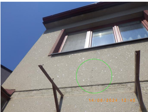
foto 77 +78 poškození povrchu omítek fasády foto 78
