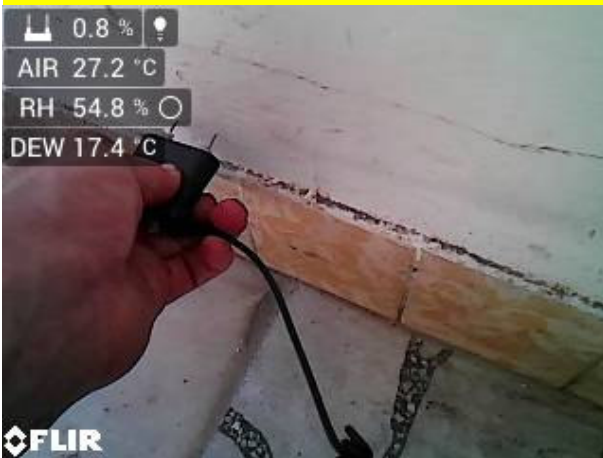
foto 15 +16 1.07 chodba vlhkost 0,8 % hm
