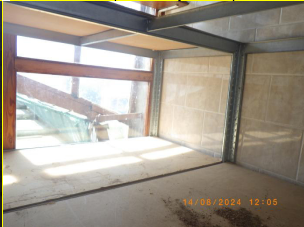
foto 63 2.05 koupelna nevylněná spára obkladu
