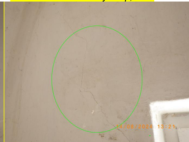
foto 42 1.10 dílna trhliny zdivo
