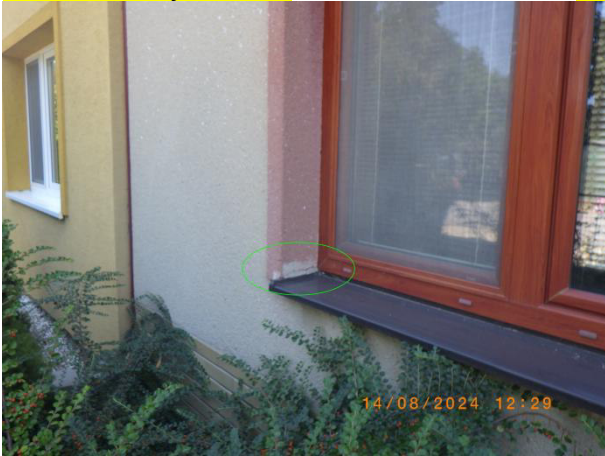
foto 81 poškození omítky
