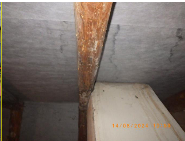
foto 71 schází 50 mm odstup od komínu
